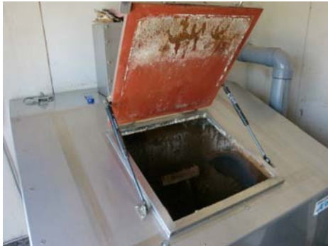
写真一 投入口開放状態
